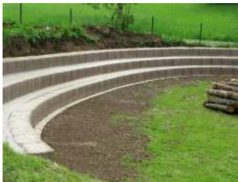
Jetzt muß nur noch das haltbare "Bankirai-Holz" auf der oberen Sitzfläche angebracht werden.
